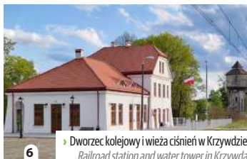
6 ▶ Dworzec kolejowy i wieża ciśnieni w Krzywdzie Railroad station and water tower in Krzywdzie
